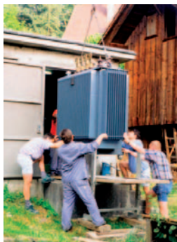
Millimeterarbeit beim Ein- bringen des Trafos in die Station
