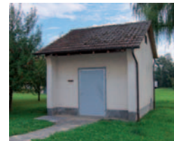
Trafostation Allmend (älteste Station)
