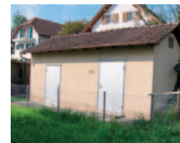
Trafostation Merenschwand Kiesgrube
